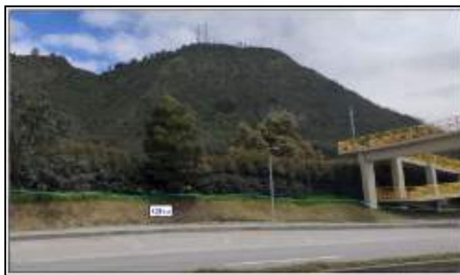
Ilustración 96. Depósitos de la Formación Sabana, al costado de la vía Cajicá-Zipacquirá, al norte del municipio costado occidental de la autopista.
